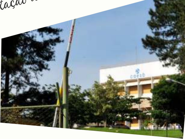
Estação de Tratamento de Água
